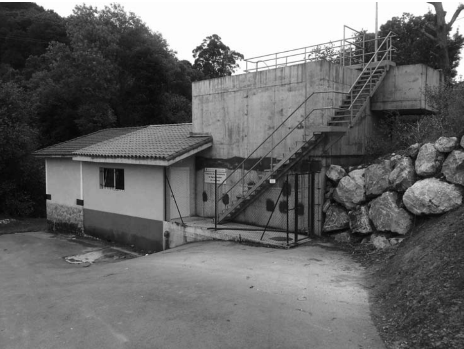
DEPURADORA EN LA LOMBANA CONSTRUIDA POR EL GRUPO REGIONALISTA
